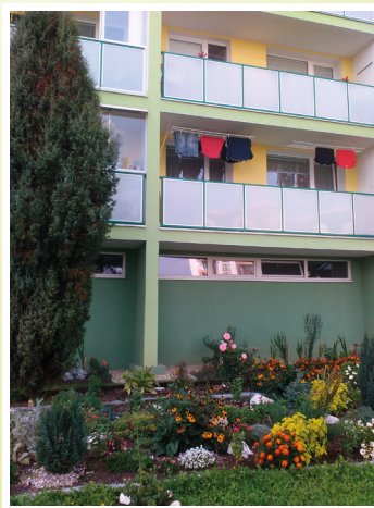
Okolie bytového domu
